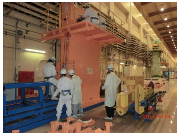
シャッターブロックの吊り上げと、大型 機器取扱作業室での 点検の様子
