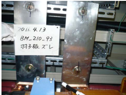
↑ 端子板(通称;羽子板)のずれ
