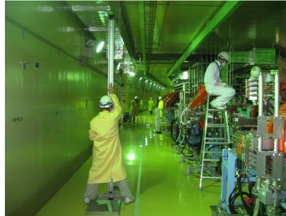
3 NBTトンネル内での 測量作業の様子
