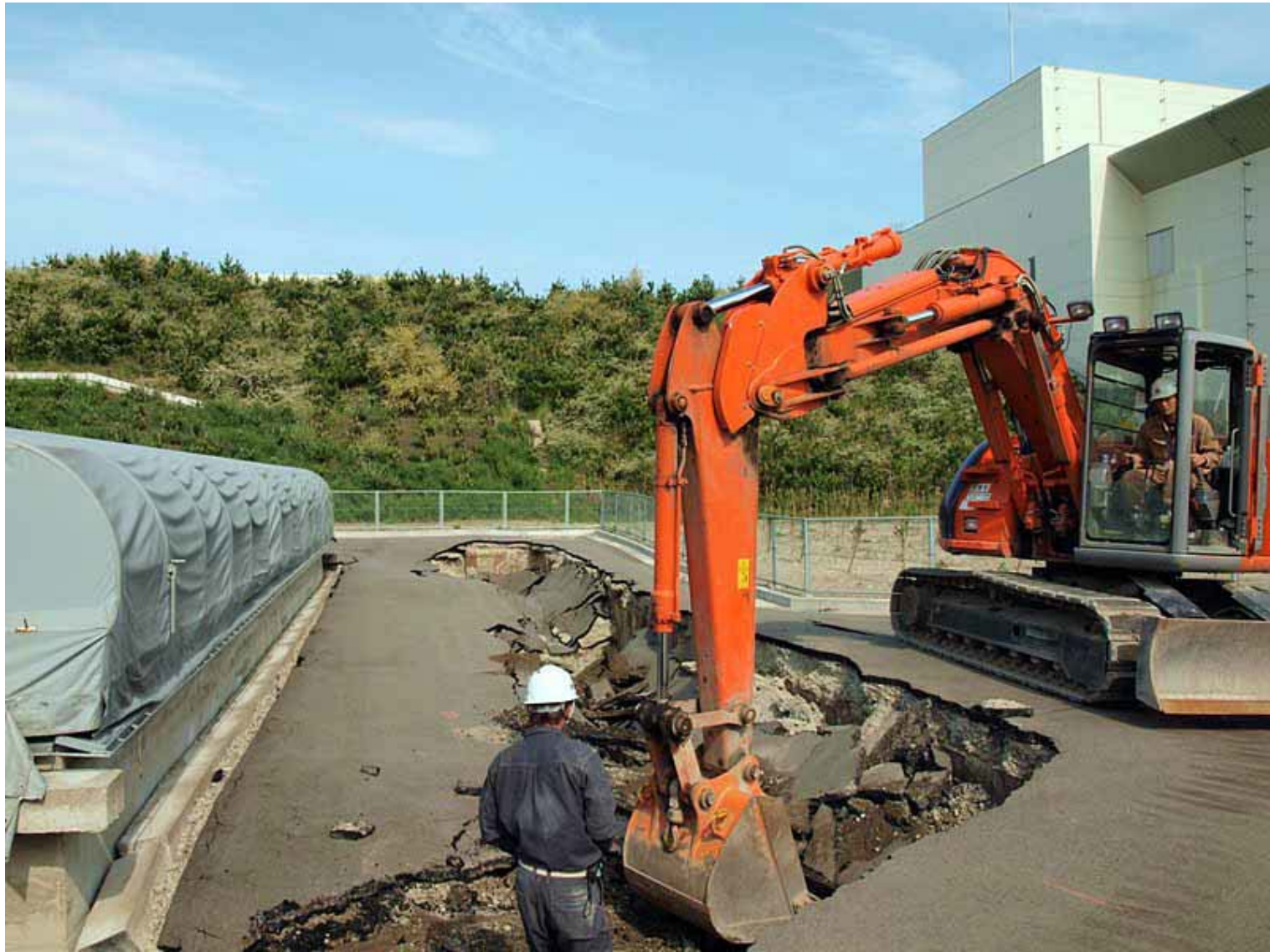
ニュートリノミュオンモニター棟。震災時に液状化現象で 陥没した個所の修復作業を実施。
