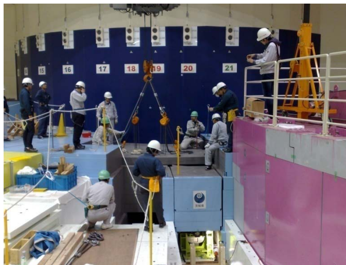
撤去作業の様子
