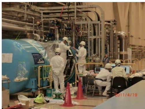
膨張タービンの点検の様子
