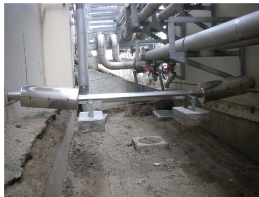
↑ 宙づりになった配管 配管ベロ一部のゆがみ →
